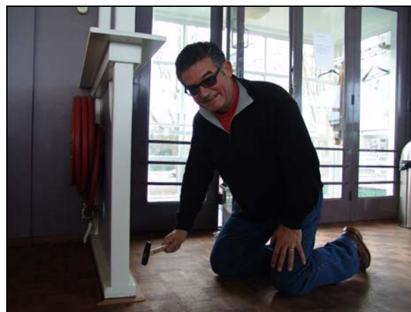
Art aan het werk in de bovenzaal
